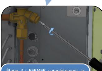
Étape 3 : FERMER complètement le détendeur (tourner le tournevis dans le sens horaire). Vérifier le bon positionnement de l'embout du tournevis (pour s'assurer du nombre exact de tours et du bon réglage du détendeur)
